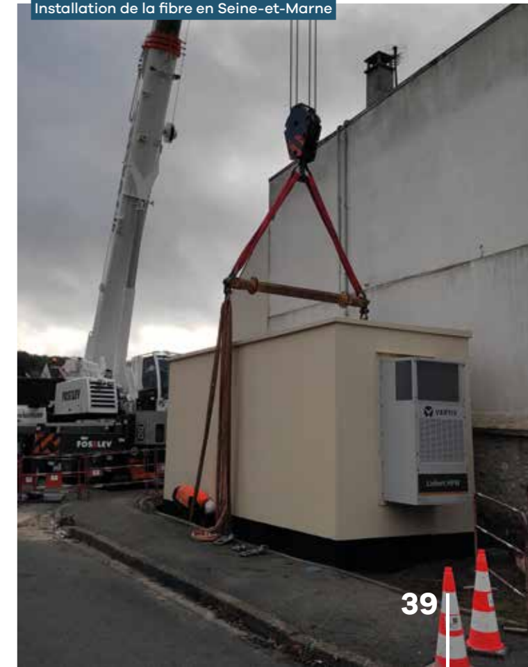
Installation de la fibre en Seine-et-Marne
