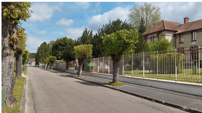
Avenue de Fussy, bordée d'alignement d'arbres – clôture d'origine
