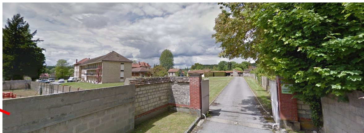
Ancienne entrée de service du site menant à la maison de santé et à l'entrée de service de l'EHPAD
