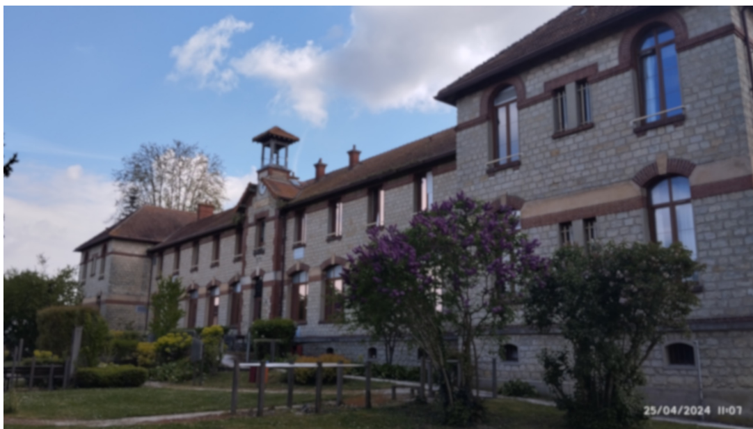
Façade sur l'avenue de Fussy du bâtiment d'origine
