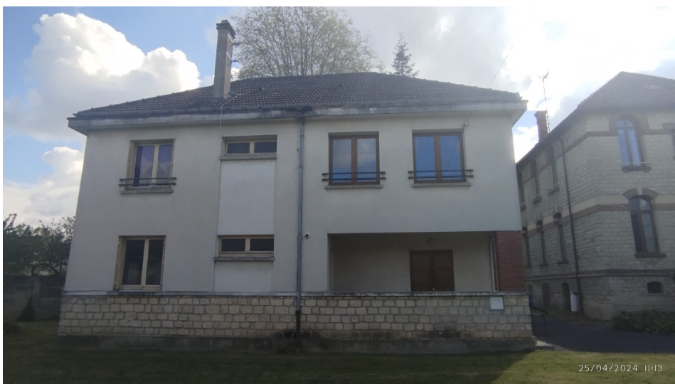
Maison individuelle accueil bureaux
