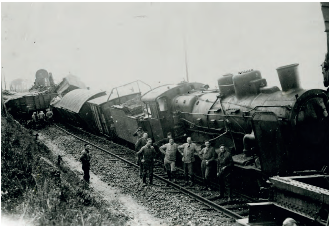
Le déraillement du 26 octobre 1943 à Grandpuits, photographie extraite du rapport de police (AD77, cote SC26488) ▼
