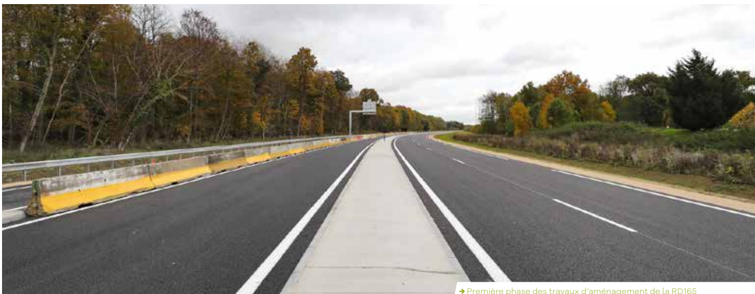
→ Première phase des travaux d'aménagement de la RD165
