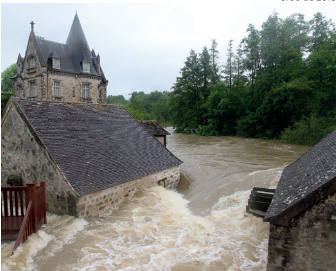
Moret-sur-Loing, crue de 2016.
