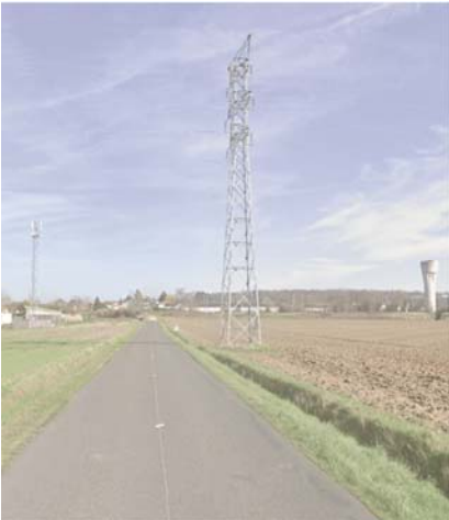
Pylône HT (sud de Verneuil-l'Etang)
