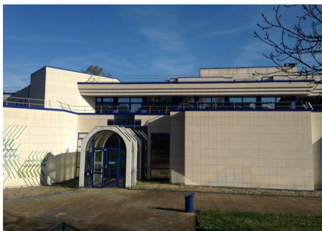
Entrée principale façade Sud
