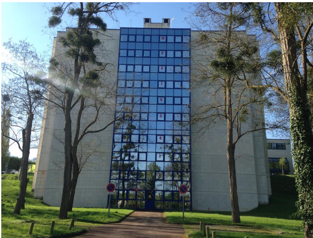
Façade nord bâtiment magasins
