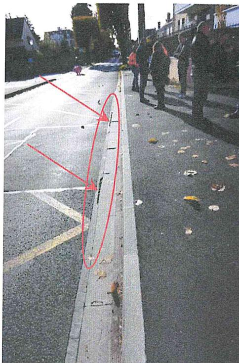
4) Désaffleurement entre le revêtement au-dessus de la tranchée de branchement et le reste de la chaussée
