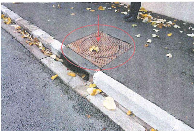
Le couvercle de la plaque du regard du caniveau est voilé, visible à cause de passage d'engins.
