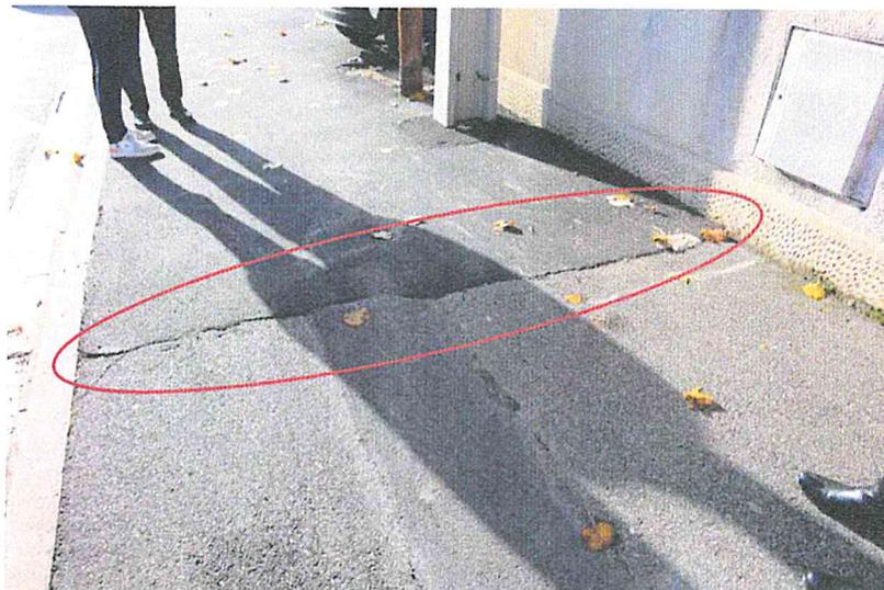
Il s'agit de la jonction entre le revêtement du trottoir et une réfection du trottoir à l'endroit de l'entrée de la résidence (partie abîmée par le passage des engins de chantier).
