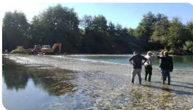
Travaux de restauration du Loing - © CD77
