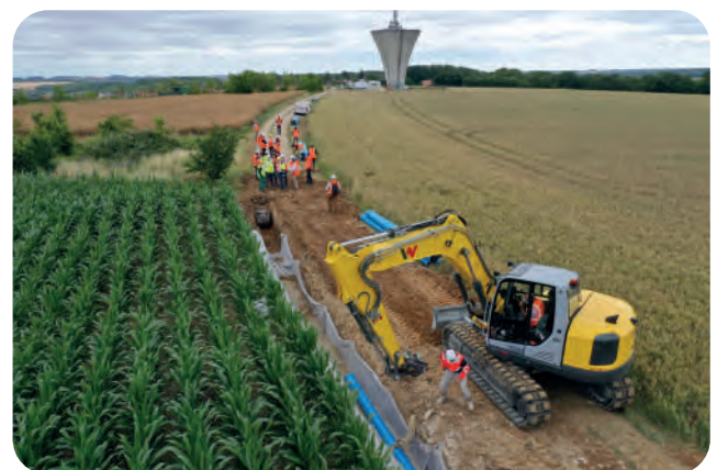
Travaux Transpr'Eauvinois - Ste Colombe - Longueville - © S2E77
