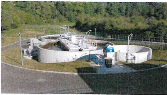
Nouvelle station d'épuration intercommunale de Machault dite « PAMAVAL » (Boues activées- 3 100 Equivalents-Habitants – mise en eau juin 2021) –SATESE ©
