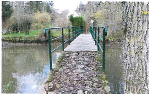
Réhabilitation d'une passerelle sur l'Yerres - Ozouer-le-Vouligis
