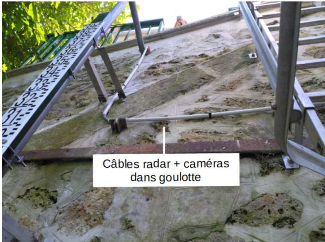
Détails sur les fixations sur la culée du pont rive gauche amont.
