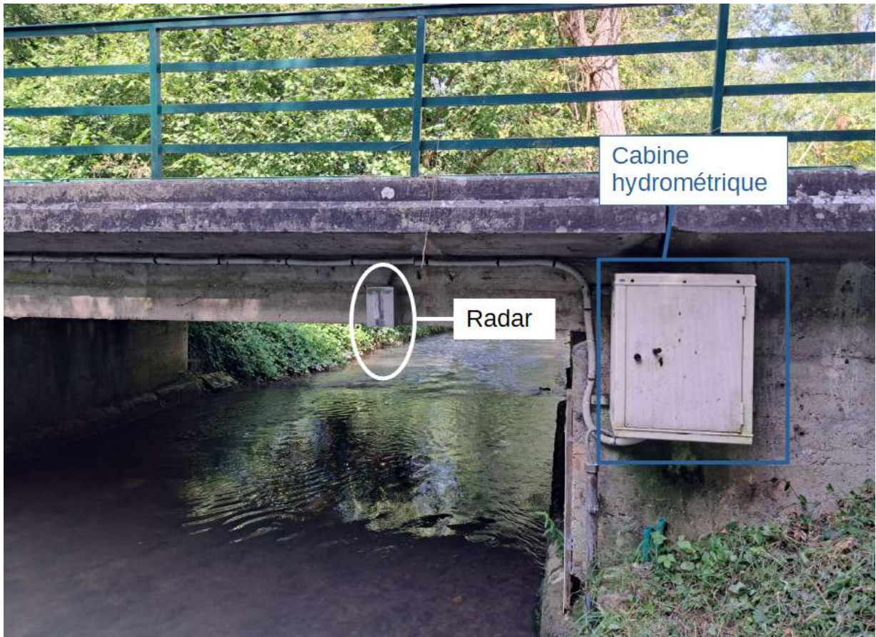
Vue vers l'aval, cabine de la station sur la culée du pont en rive droite et radar sous le pont.
