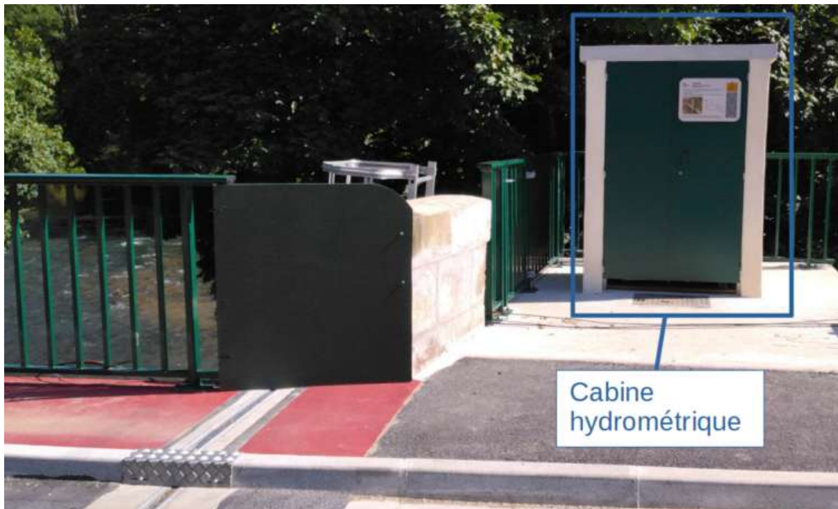
Vue vers l'amont, en rive gauche, cabine de la station sur la culée du pont.
