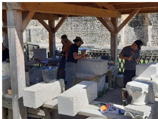
Chantier d'insertion pour des travaux de réhabilitation du patrimoine
